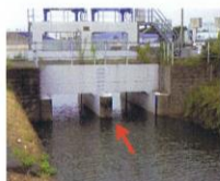
1. 前川左岸樋門
