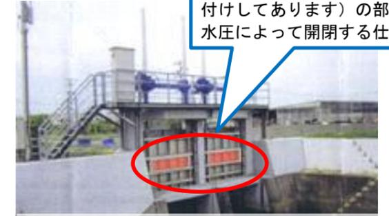
オレンジ色（わかりやすく色付けしてあります）の部分が水圧によって開閉する仕組み
